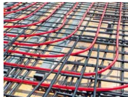
Obr. 2 Systém s rúrkami zabudovanými v masívnej betónovej konštrukcii pred betonážou [4]
