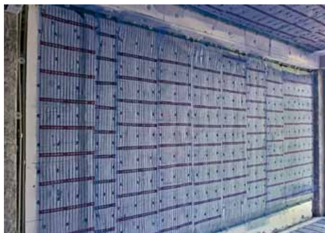
Obr. 6 Kapilárne rohože inštalované v podlahe, stene a strope, polyfunkčná budova EAST Point
