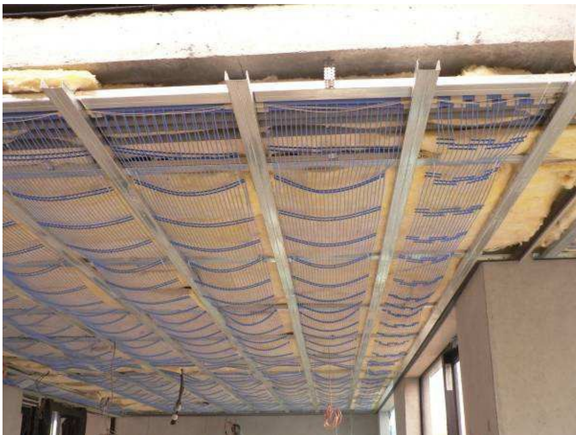
Obr. 2 - Inštalácia pod strop suchým procesom s tepelnou izoláciou
