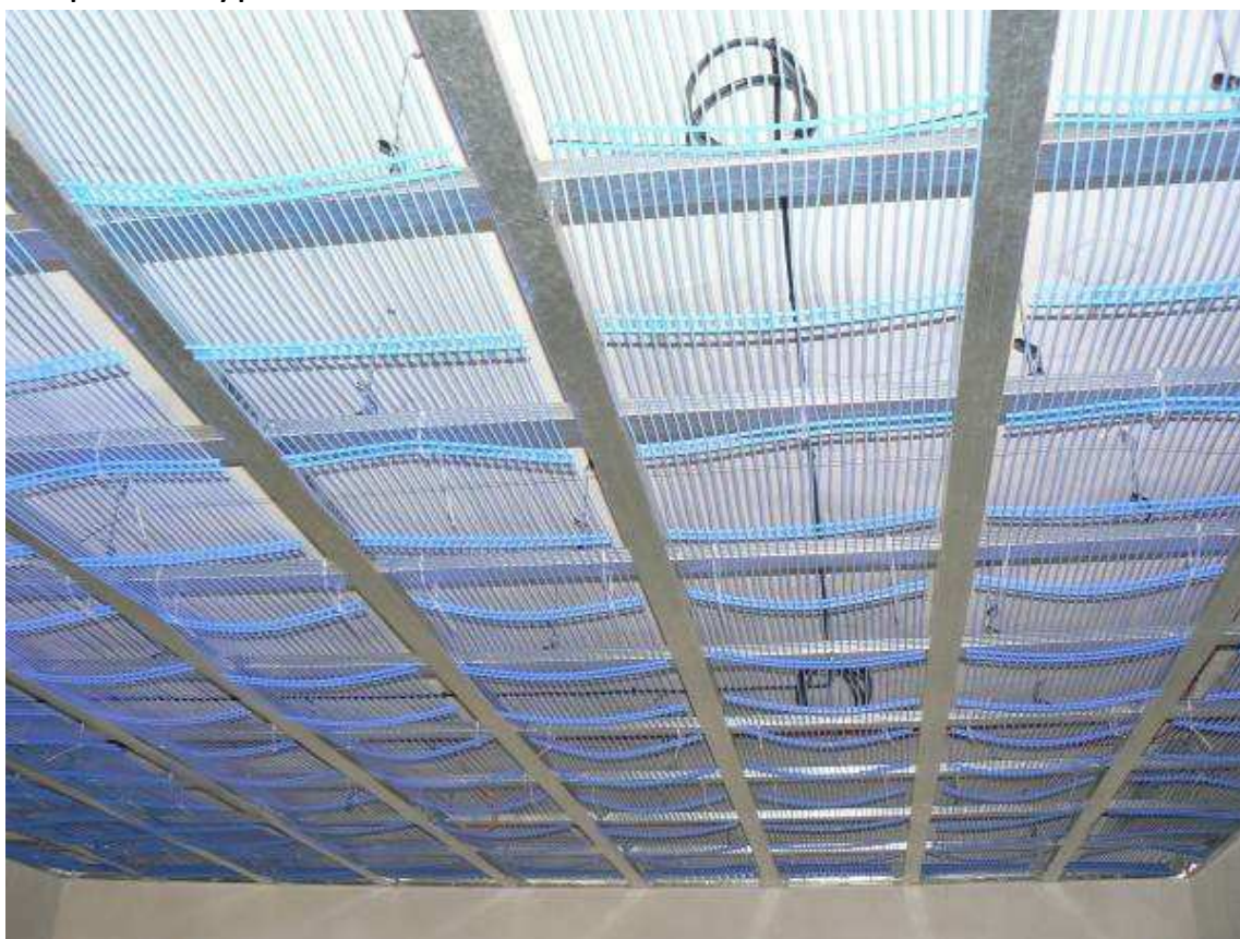
Obr. 1 - Inštalácia KR pod strop suchým procesom bez tepelnej izolácie
